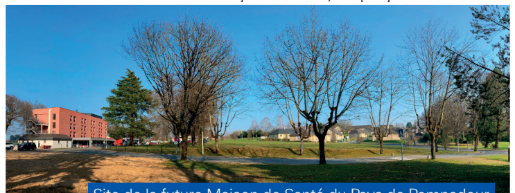
Site de la future Maison de Santé du Pays de Pompadour
