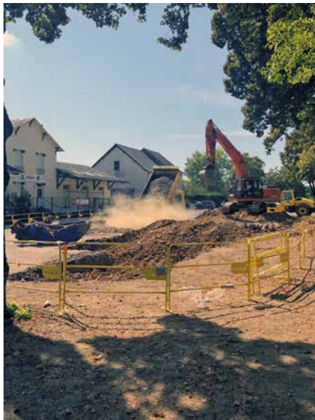
Démolition de la bascule et du quai (Champ de Foire)
