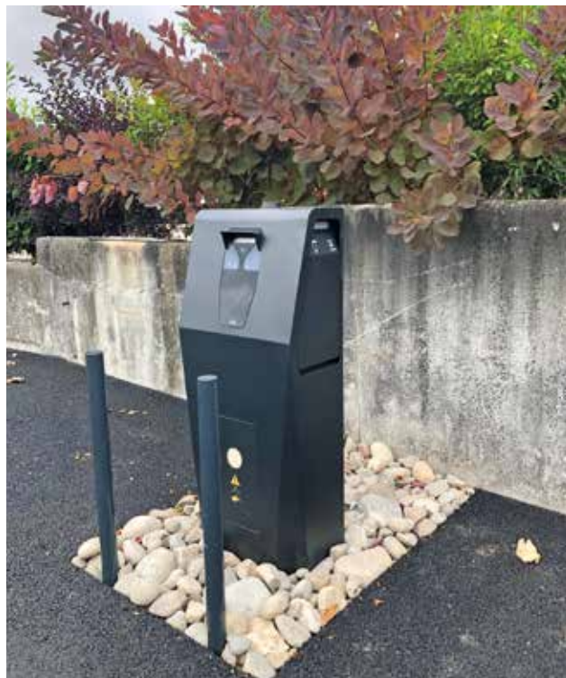
Aménagement d'une borne électrique (avenue du Château)
